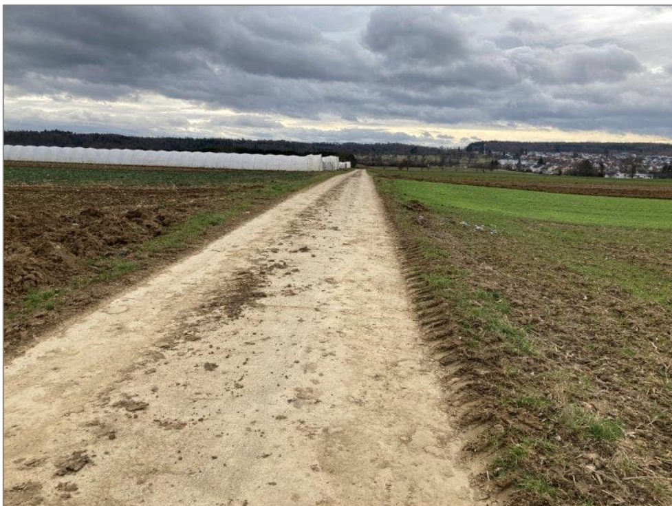
Abb. 17: Zuwegung Flst. Nr. 1279: Asphaltierter Wirtschaftsweg (südlicher Abschnitt) (Foto: HPC AG, 07.02.2024)
