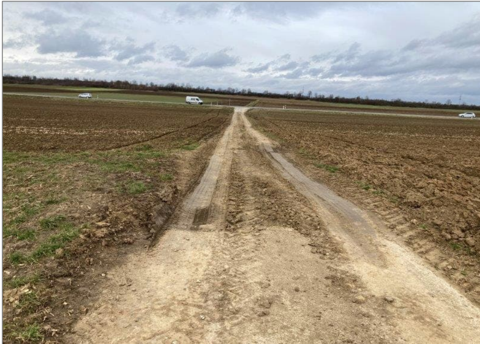
Abb. 18: Zuwegung Flst. Nr. 1279: Unbefestigter Wirtschaftsweg (nördlicher Abschnitt) (Foto: HPC AG, 07.02.2024)
